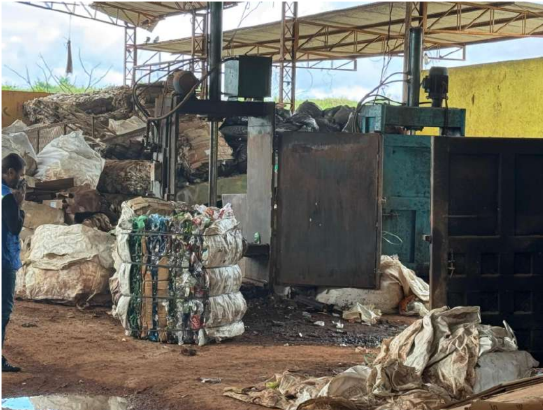
FIGURA 76 – GALPÃO DO CENTRO DE TRIAGEM DE PORTO VELHO
