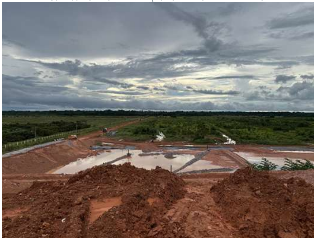
FIGURA 66 – OBRAS DE AMPLIAÇÃO DO ATERRO EM ANDAMENTO
