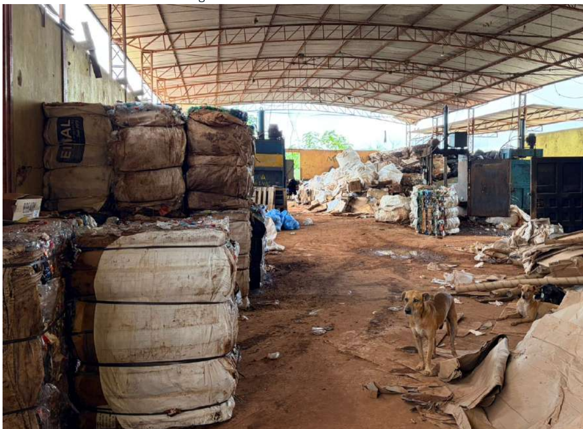
Figura 74 – GALPÃO DE RECICLAGEM
